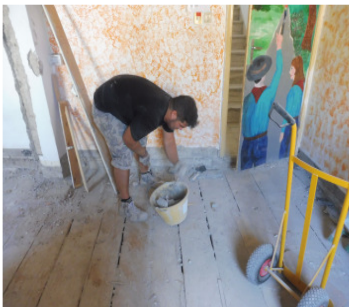
Si demolisce la cucina per ricostruirla
